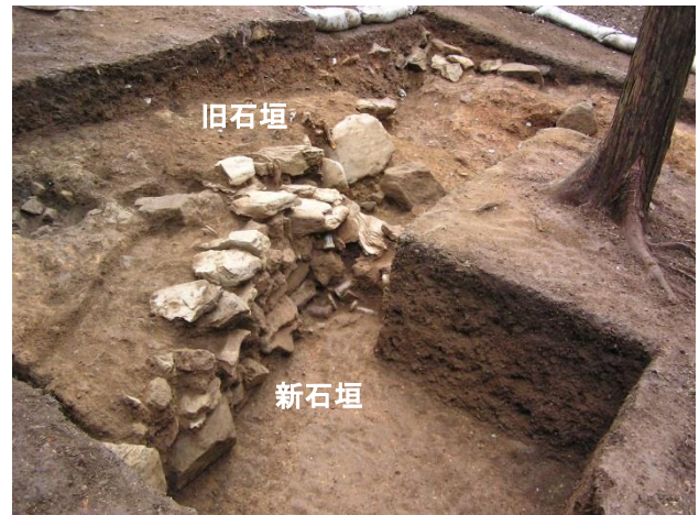
第 8 室付近空間地（北東から）
